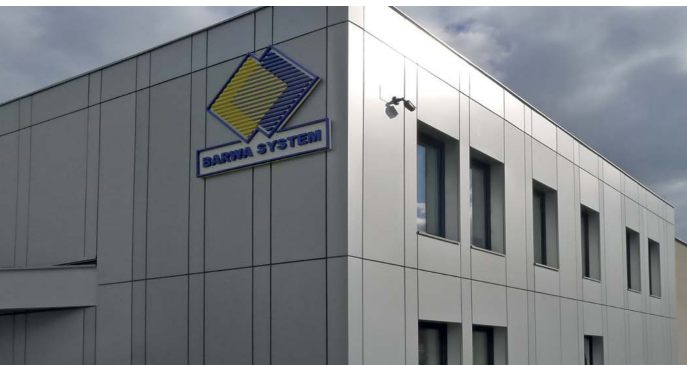
Siedziba BARWA SYSTEM, Filia Katowice DNA Works Okładziny elewacyjne z kasetonów z płyty kompozytowej, SYSTEM EL-K2.
