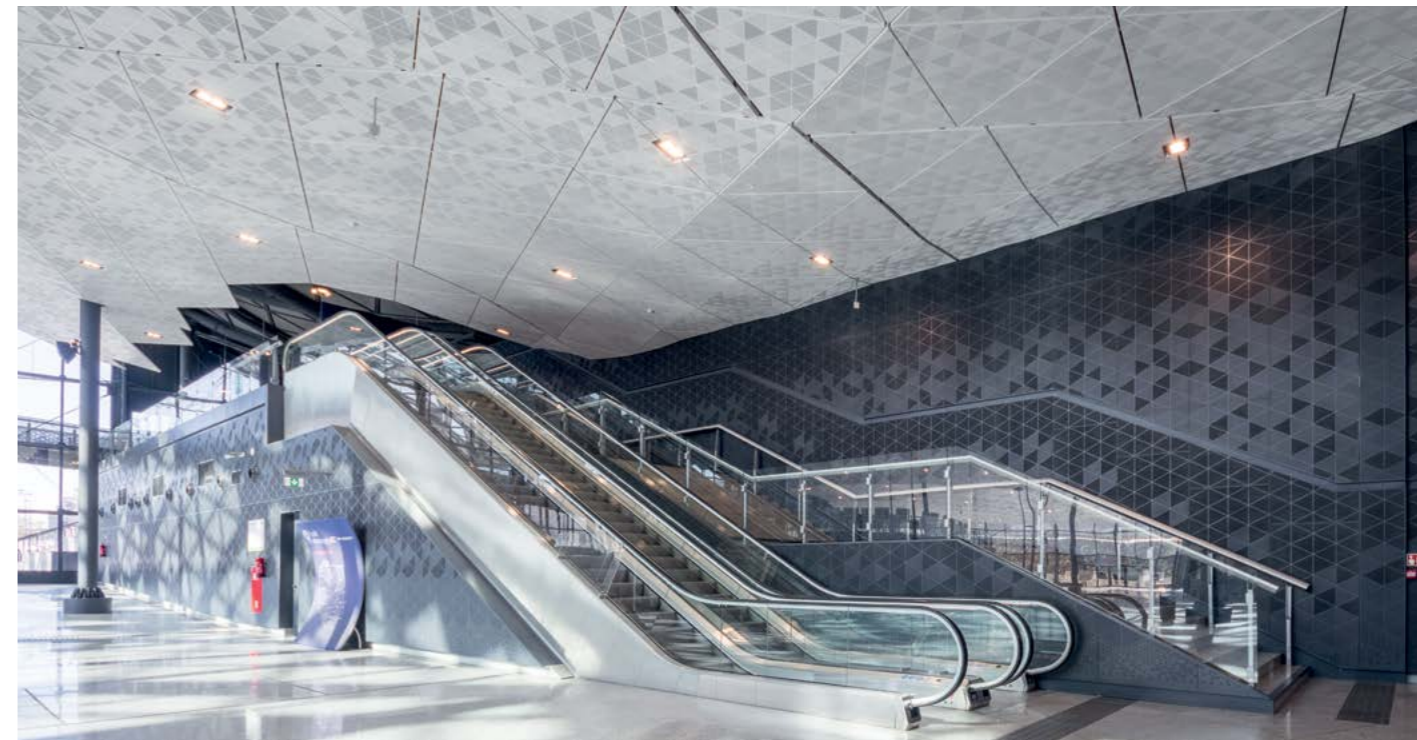
Dworzec Łódź Fabryczna FBT Pracownia Architektury i Urbanistyki Okładziny panelowe z blachy z perforacją gradientową PV5 z wkładem akustycznym, SYSTEM EL-B1.
