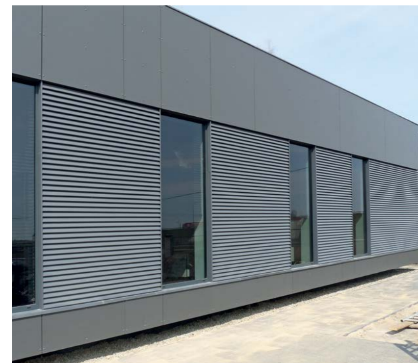
Przedsiębiorstwo Energetyki Ciepłej, Gliwice
